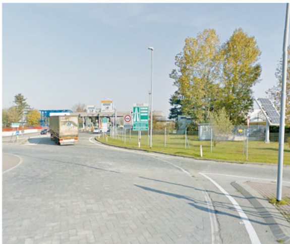
Il casello autostradale di Gropello Cairoli è attualmente il più vicino all'interporto
